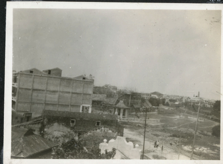
TOI SHAN CITY - N. VIEW
