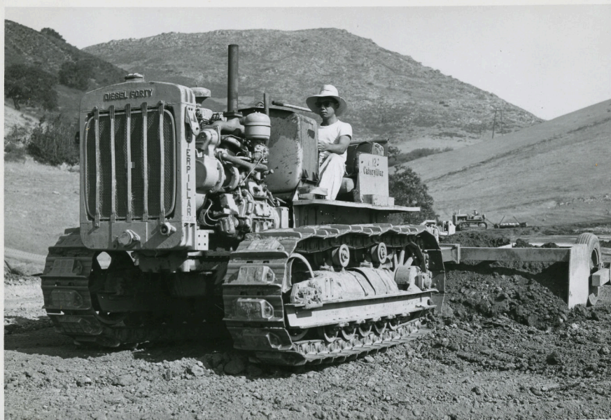
Pulling the Be-Geo.
