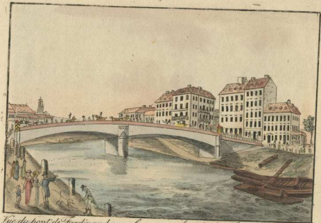
Vue du pont de Ferdinand vers le N o 58. Ansicht der Ferdinandsbrücke fauxbourg dit. Leopoldstadt. gegen die Leopoldstadt hin.
