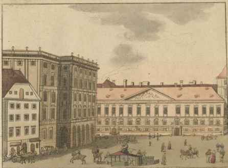
Bâtiment dit Mehlgrube N o 48. au Marché neuf ou de farine
