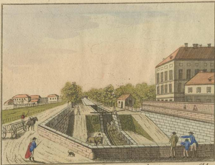
Vue de la Seconde Ecluse du N o 50. Ansicht der zweiten Schleuse des Wiener Canals.
